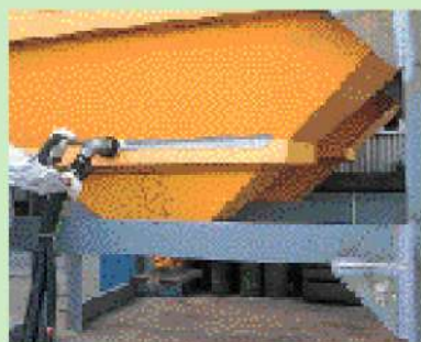
■ 溶接部の作業に
