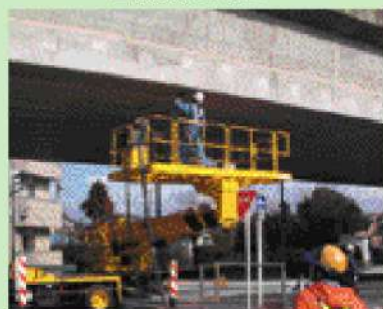
■ 高所天井部の研掃作業に
